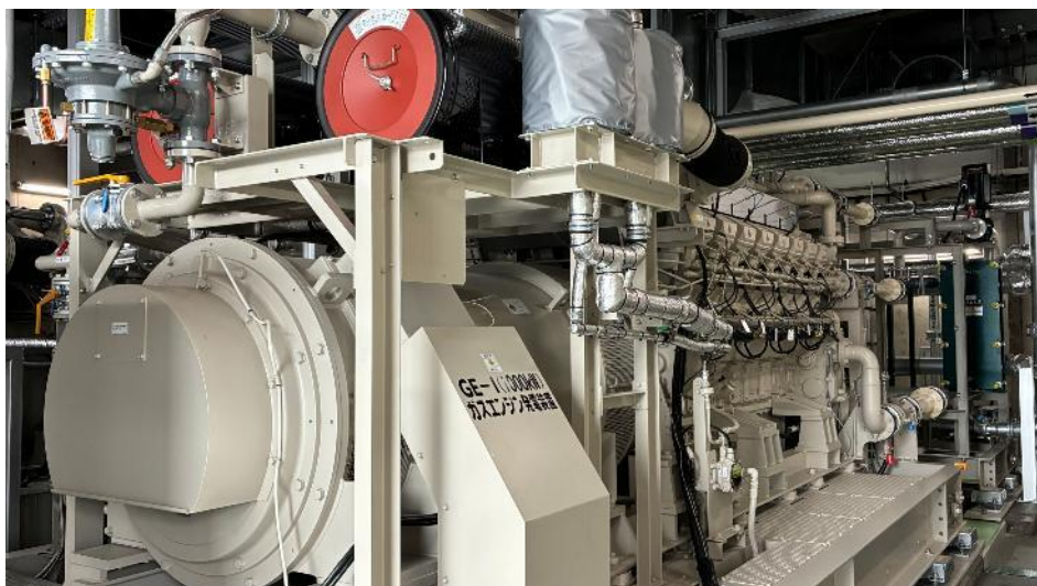
コージェネレーションシステム（発電容量：1,000kW、850kW）
