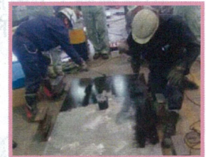
プライマーA・B塗布
