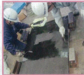
1次接着剤塗布 摩擦素子粒子散布・転圧
