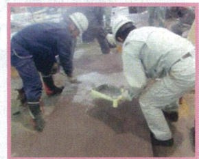
2次接着剤塗布 摩擦素子粒子散布・転圧
