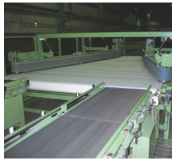
DC-I 物流センターのマジコンベヤ
